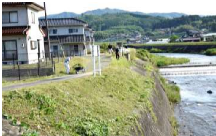
こぶし地区の布野川堤防の除草作業
